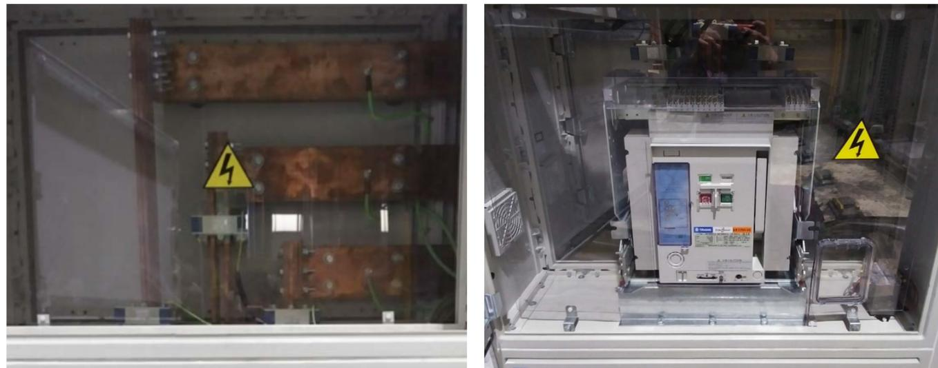
En el módulo Superior se encuentra parte del embarrado de cobre con los transformadores de corriente.
